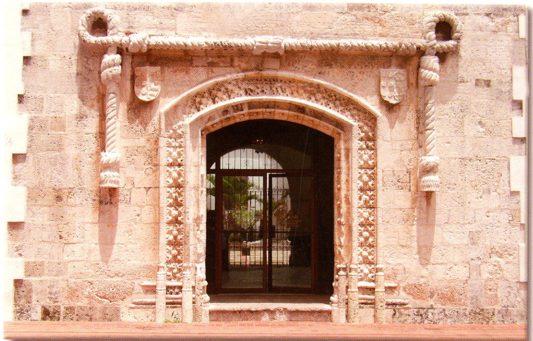
Casa del Cordón
